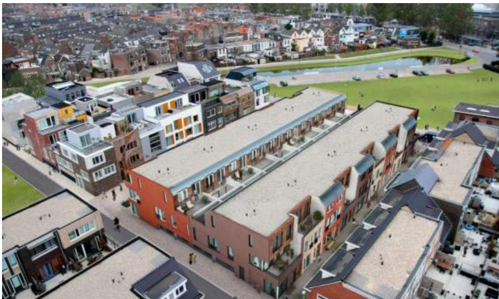
▲ Grondgebonden woonmilieus (met voordeuren aan de straat) in hoge dichtheid; Nieuw Leyden
